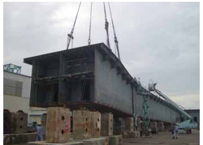
-1 仮組立 (正しい形に組立てられるかを確認)
