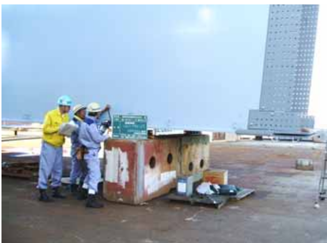
-2 塗装確認 (きれいに塗られているか確認)
