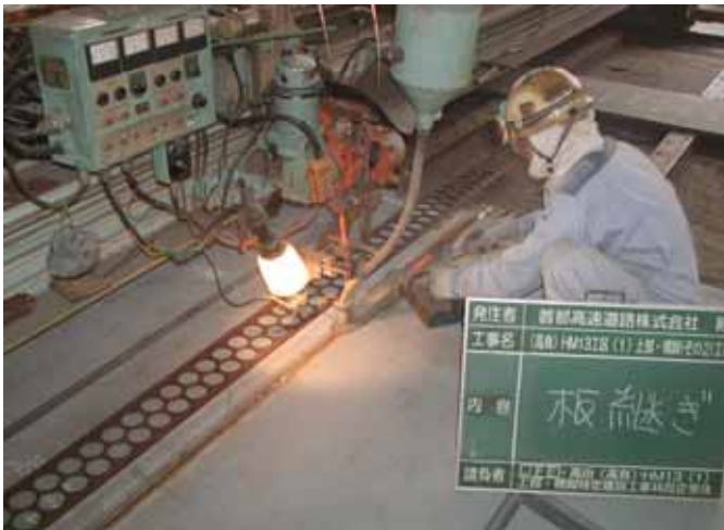
-1 溶接（板と板をつなぐ）
