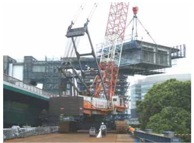
架設（クレーンで持ち上げる）
