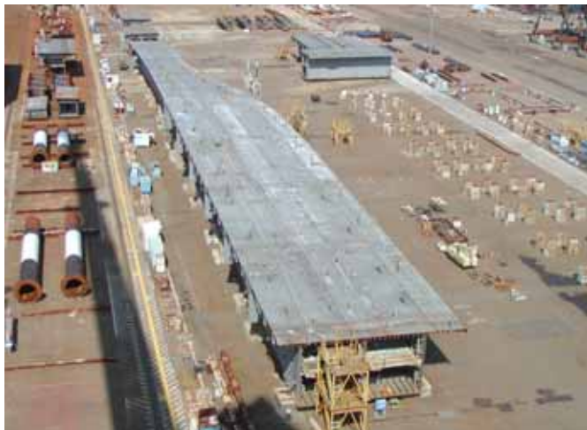
-2 仮組立 (正しい形に組立てられるかを確認)
