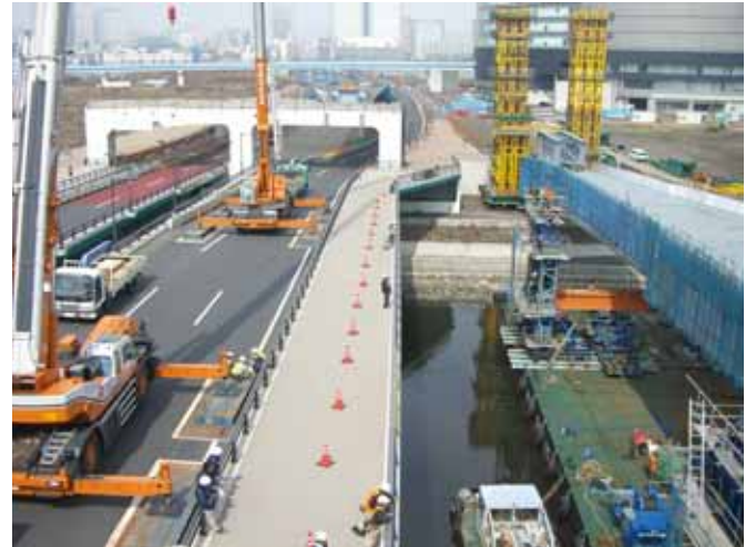
-1 架設（運河上に1日で架ける）
