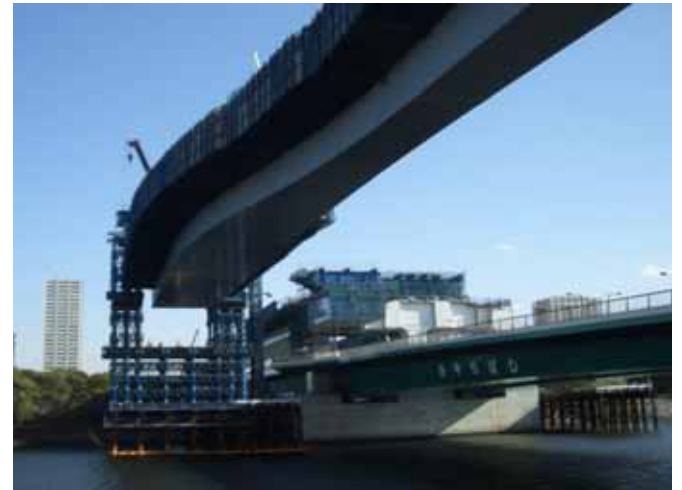
吊上げ （高速道路の高さまで12m吊上げる）
