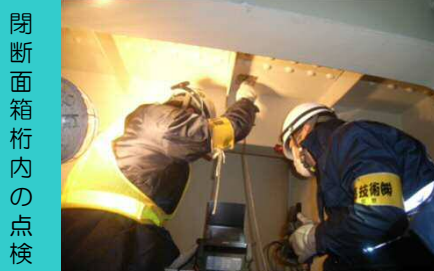
ビデオスコープを使用した点検状況
