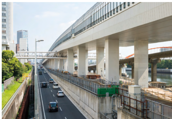
う回路を通しながら進む更新工事
