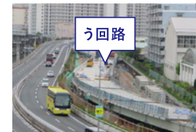
構築中のう回路(2017年5月撮影)
