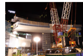
巨大な新しい橋げたの架け替え (2019年1月撮影)
