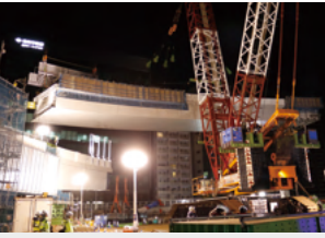
巨大な新しい橋げたの架け替え(2019年1月撮影)
