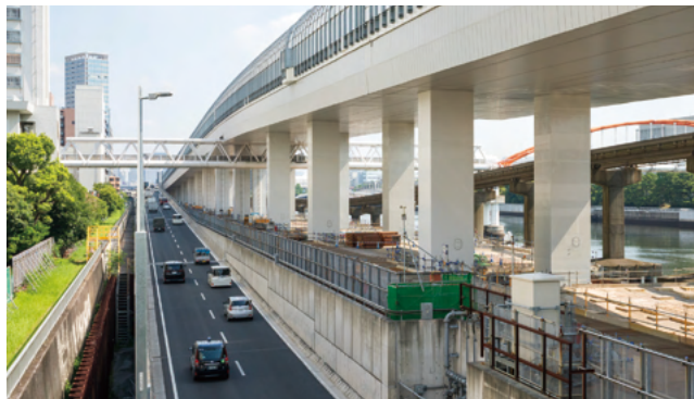
う回路を通しながら進む更新工事
