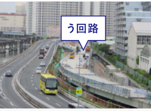
構築中のう回路(2017年5月撮影)
