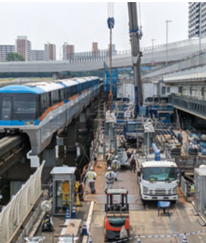
現場のすぐ横を走るモノレール(2024年3月撮影)
