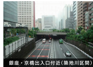
銀座・京橋出入口付近(築地川区間)
