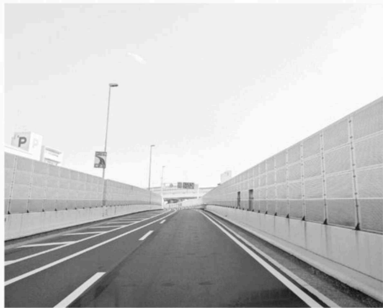
事故を防ぐ安全対策をした石川町JCT(横浜市中区)
