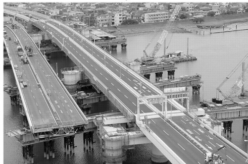
1号羽田線の多摩川に架かる「高速大師橋」の架け替え工事の様子(上がスライド中、下がスライド後)
