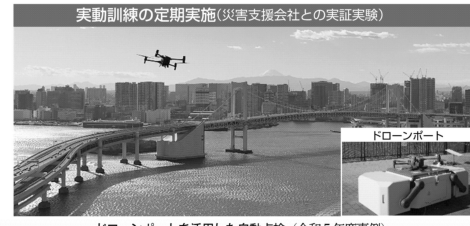
ドローンポートを活用した自動点検 (令和5年度事例)
