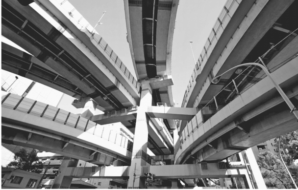
高架橋が重なり合う複雑な構造をした箱崎ジャンクション―東京都中央区
