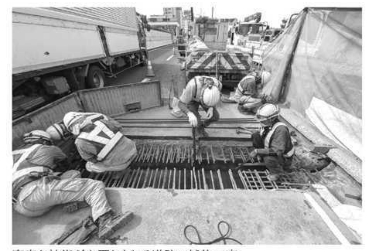
高度な技術が必要とされる道路の補修工事
