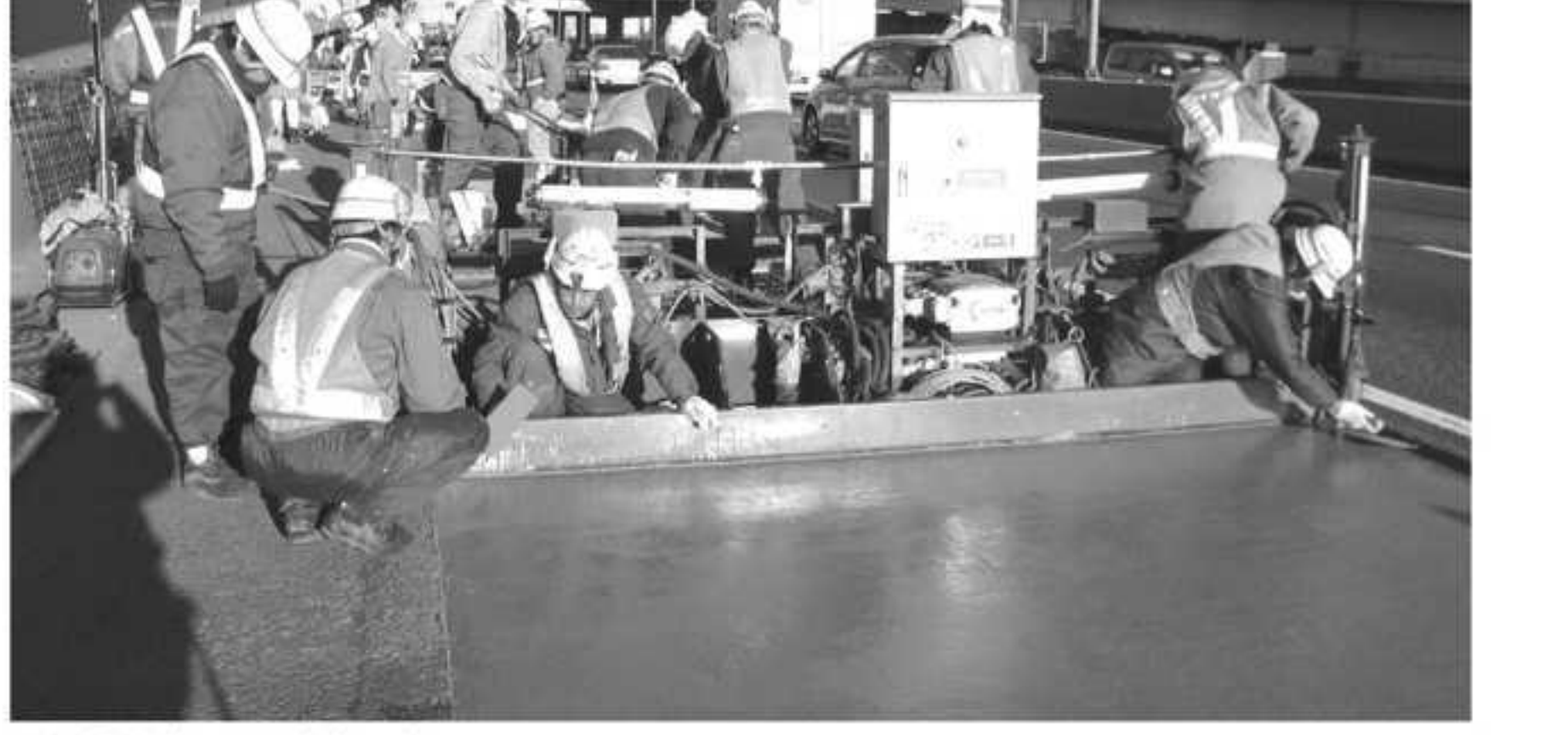
大規模修繕による舗装工事
