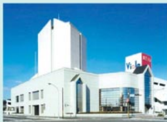
高速湾岸線並木トンネル 並木換気所 (横浜市金沢区並木町)
