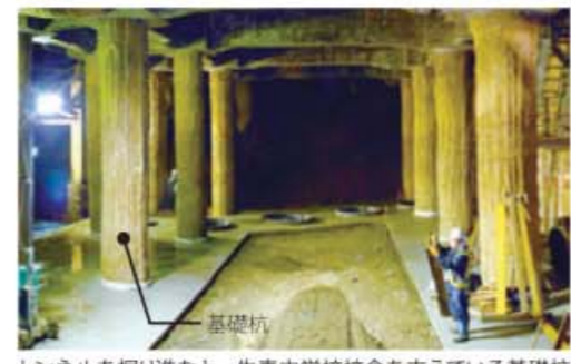
トンネルを掘り進むと、生麦中学校校舎を支えている基礎杭にぶつかってしまうので、トンネルと当たらない位置に新しい基礎杭を設置して校舎を支える工事をしています。写真は校舎の下を掘削して基礎杭が現れた状況です（2005年10月時点）。
