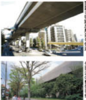
遮音壁 (透光タイプ) 高速湾岸線の整備事例
