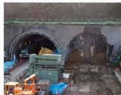
「防音ハウス」が設置される前の国道1号側坑口。
