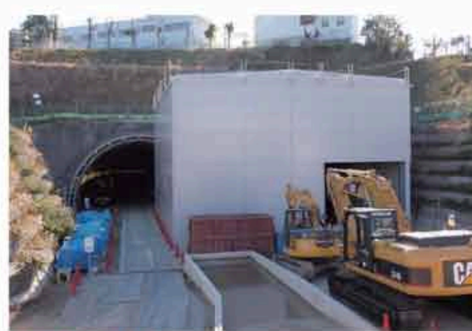
国道1号側坑口。左は平成19年に掘削が完了した生麦方面行きトンネル。12月に設置された「防音ハウス」は幅18.5m×高さ10m×奥行き20m。防音材（グラスウール）の厚さは10cmで、数高品質のものが使われています。
