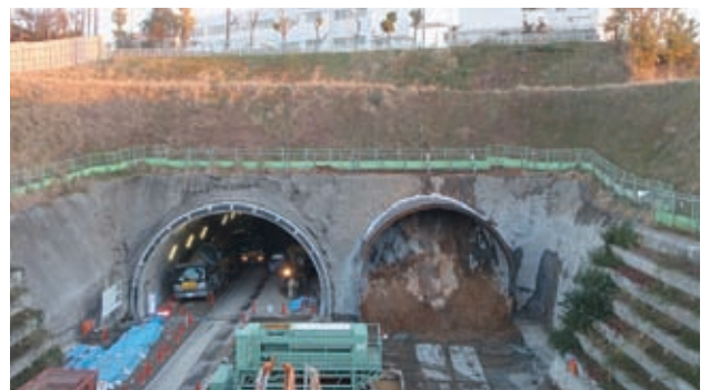
〈岸谷生麦線〉国道1号側坑口部 (国道1号側から眺む)
