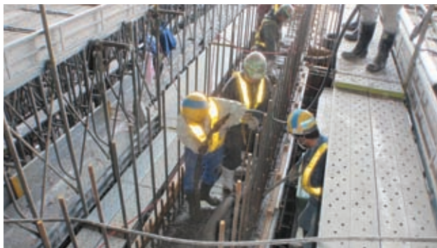
② トンネル・換気所・受変電棟部 (トンネル部4F壁打設状況)
