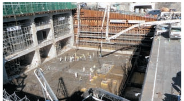
③ トンネル・換気所・受変電棟部 (換気所部1F床版打設状況)
