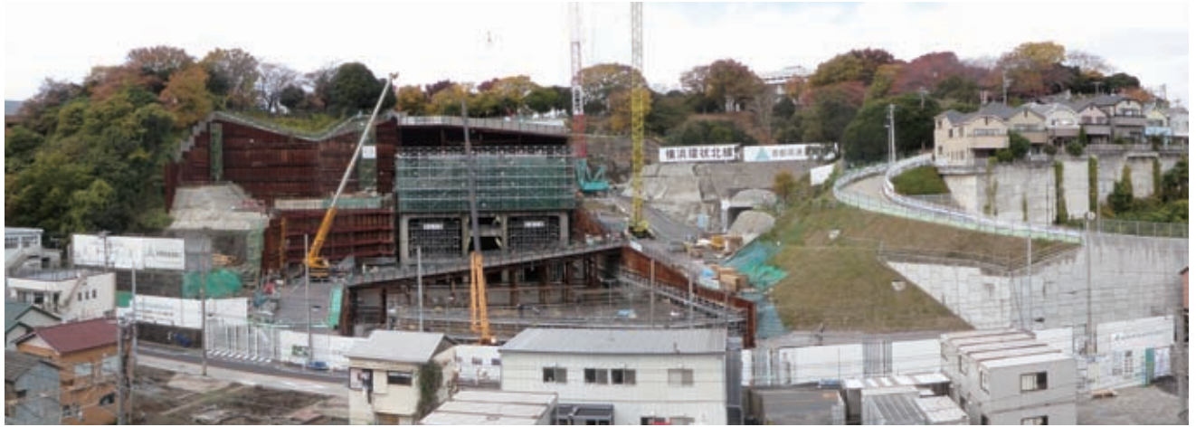
〈横浜環状北線〉① トンネル・換気所・受変電棟部 (学園通り側から眺む)
