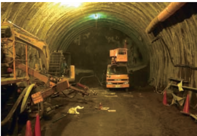
<岸谷生麦線>①トンネル掘削工（坑内全景）
