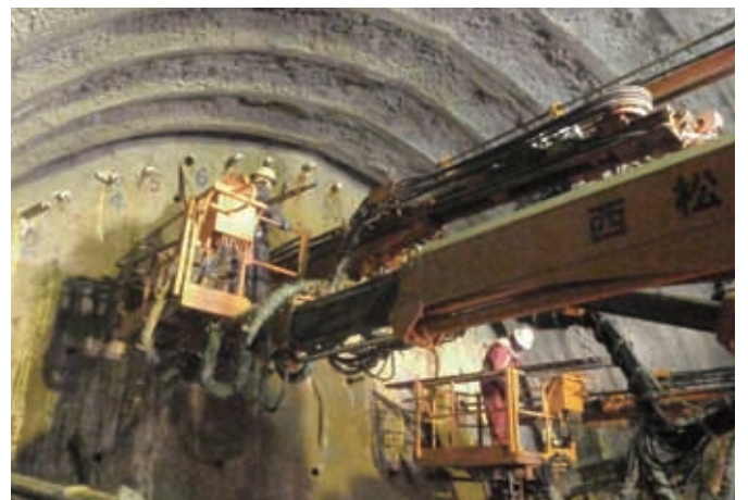
②トンネル掘削工（補強工施工状況）
