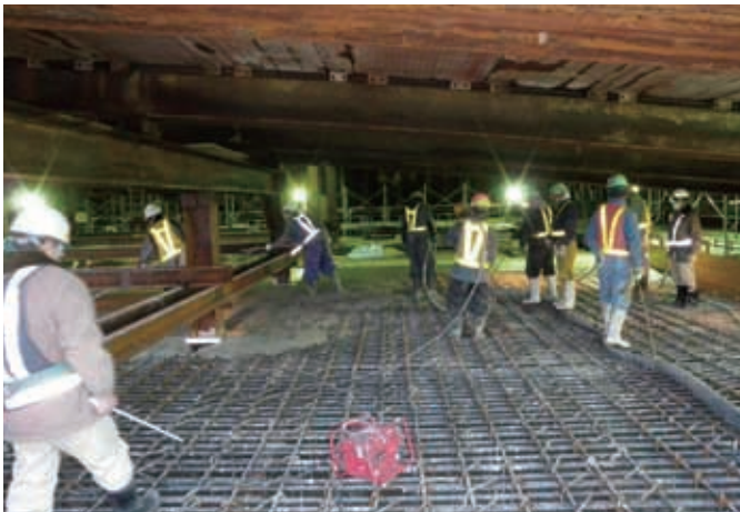
②トンネル・換気所・受変電棟部（トンネル部頂版打設状況）
