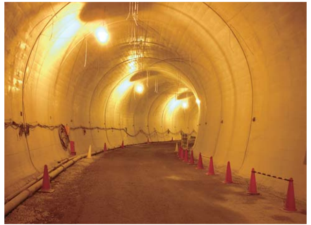
<岸谷生麦線>トンネル覆工(コンクリート打設完了状況)
