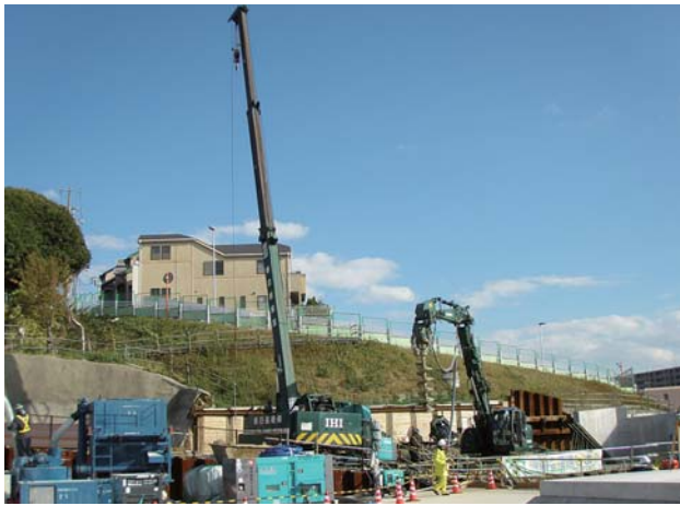
<横浜環状北線>鉄道交差部 作業構台設置工
