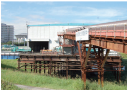
④ 鶴見川遊水地部 (土砂搬出ヤード状況)
