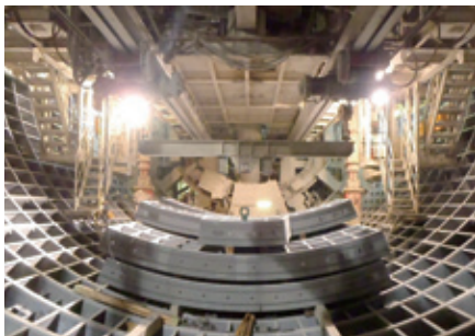
③ シールドトンネル内部状況 (トンネル先端付近の状況)
