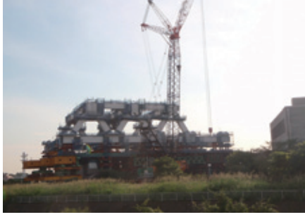
①-1 大竹橋付近工事状況 (トラス橋架設状況 (遠景))
