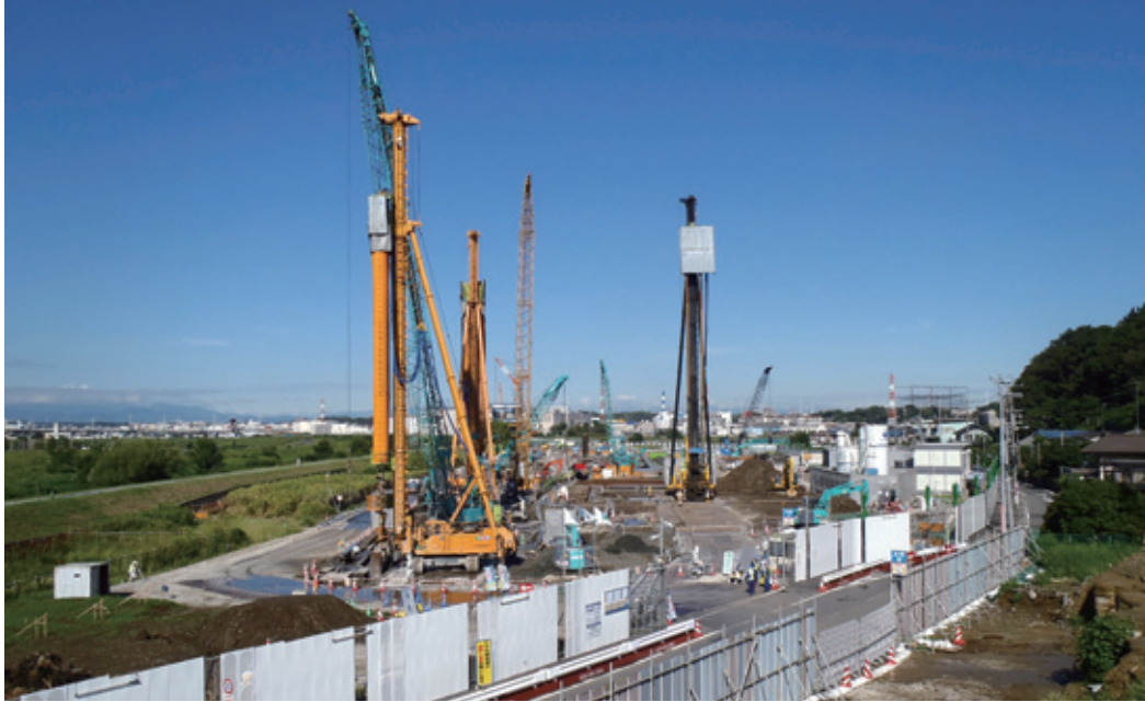
②-2 新横浜出入口工事状況 (工事ヤード全景状況)
