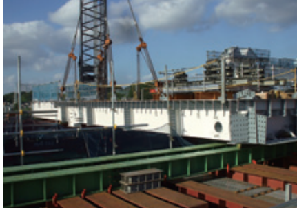
①-2 大竹橋付近工事状況 (トラス橋架設状況 (近景))
