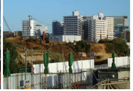
②-1 新横浜出入口工事状況 (亀甲山掘削状況)
