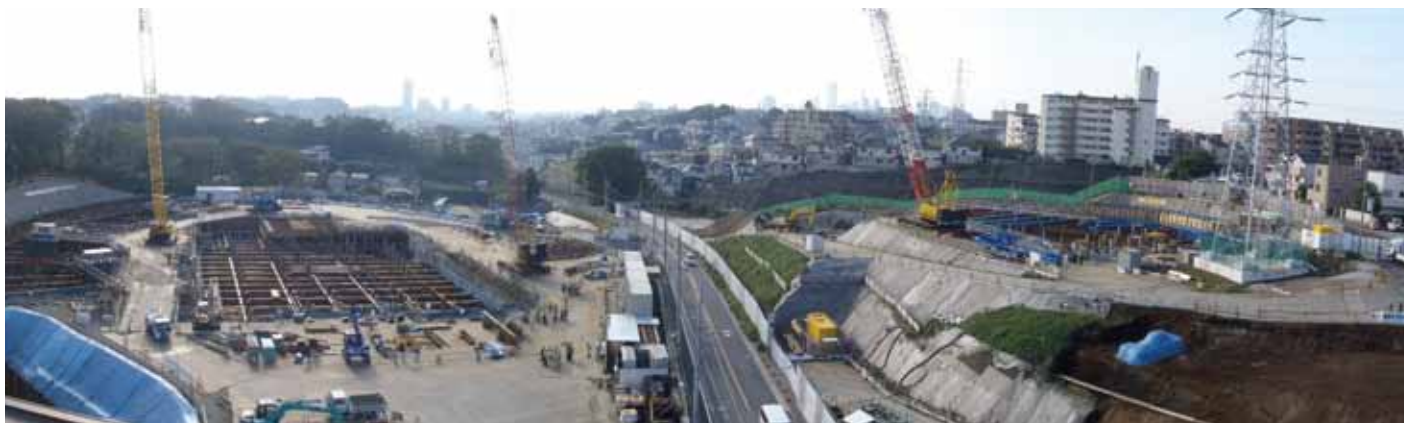
① 馬場換気所および出入口トンネル部ヤード工事状況(全景)
