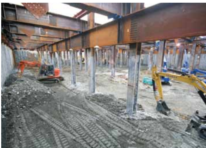
② 馬場換気所ヤード 換気所部(掘削状況)
