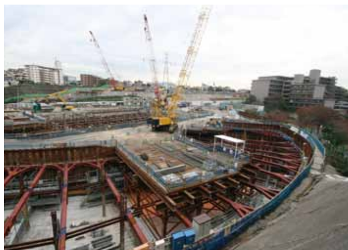
③ 馬場換気所ヤード 出入口トンネル発進部(躯体構築状況)
