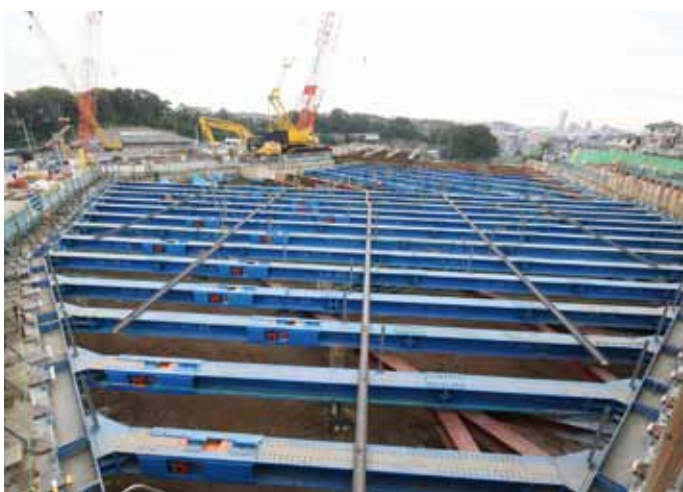
④ 馬場出入口トンネルヤードトンネル発進部(掘削状況)
