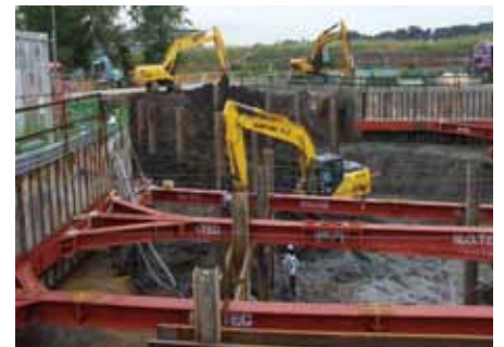
②-2 新横浜出入口部工事状況 (掘削土留工)
