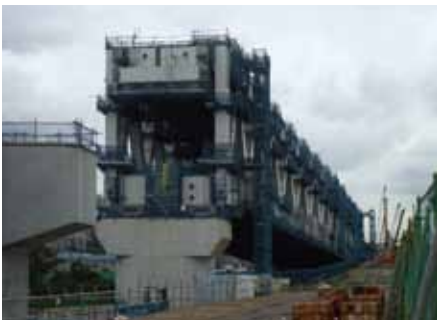
①-2 大竹橋付近工事状況 (西側:川向町側から)
