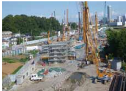
②-1 新横浜出入口部工事状況 (全景)
