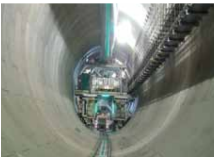
③-1 発進立坑部工事状況 (シールドトンネル先端部)
