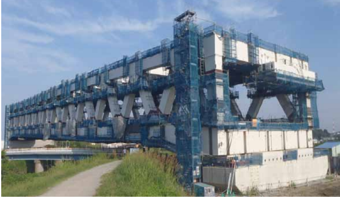
①-1 大竹橋付近工事状況(東側:新羽町側から)
