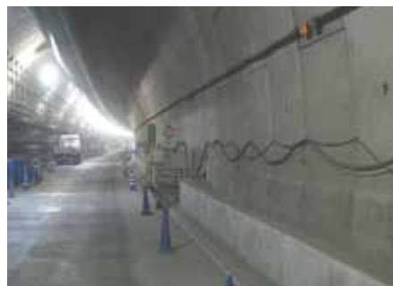
③-2 発進立坑部工事状況 (シールドトンネル床版設置状況)
