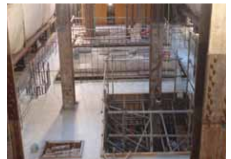
⑤ 新横浜換気所部工事状況 (躯体構築状況)
