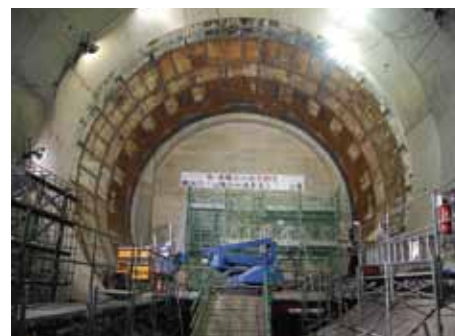
⑦ 本線シールドトンネル内部状況
