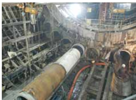
⑥ 本線シールドトンネル拡幅部工事状況
