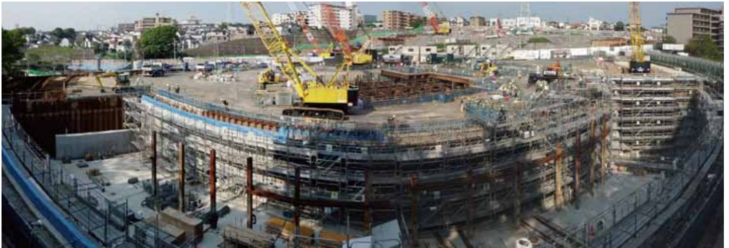
① 馬場換気所ヤード工事状況(全景)
