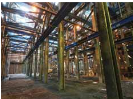
② 馬場換気所ヤード 馬場換気所部(掘削状況)
