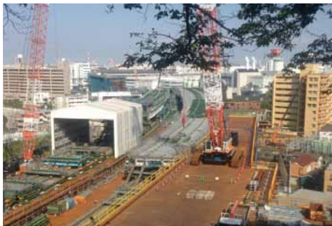
④ 鉄道交差部の桁地組状況(子安台公園から眺む)
