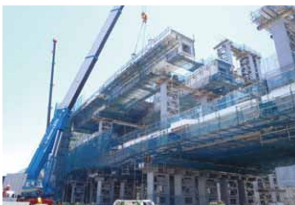
③ 橋げた架設状況
