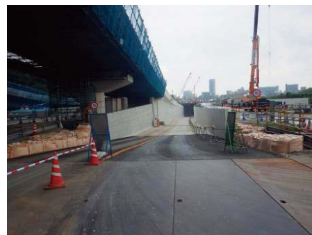
②-2 新横浜出入口部工事状況 (躯体構築工)
