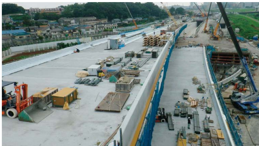
②-3 新横浜出入口部工事状況 (全景)
