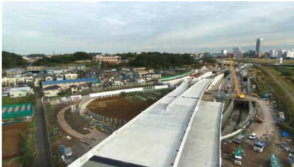
②-3 新横浜出入口部工事状況 (全景)
