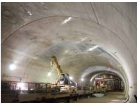
③ シールド工事状況 (本線シールドトンネル拡幅工事状況)
