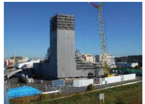
⑤ 新横浜換気所部工事状況 (地上部全景)
