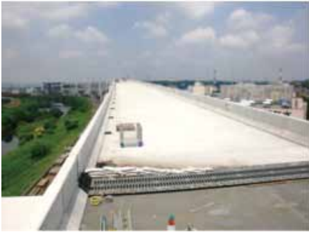
① 大竹橋付近工事状況 (大竹橋以西)
