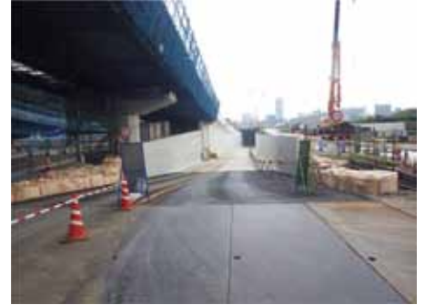
②-2 新横浜出入口部工事状況 (躯体構築工)
