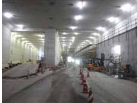
②-1 新横浜出入口部工事状況 (躯体構築工)
