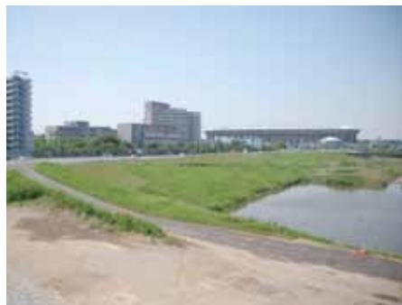
④ 鶴見川遊水地部 (土砂ピット解体完了状況)
