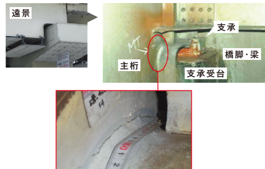
鋼桁の接続部（切欠き部）
