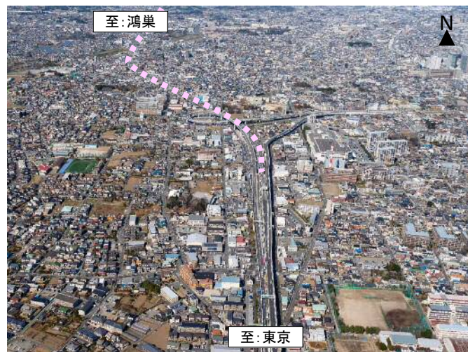
与野JCT(仮称)付近
