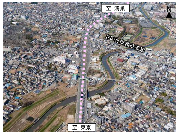
三橋5丁目付近
