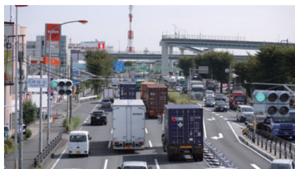
国道17号バイパスの現状（与野JCT（仮称）付近）
