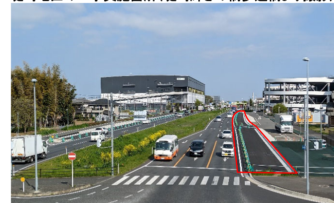
上り線の工事実施箇所（令和5年3月末現在）
