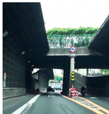
同方向車道間の橋脚を撤去
