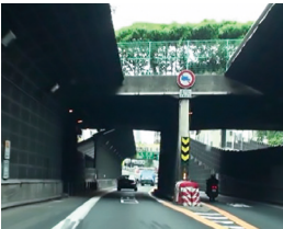
同方向車道間の橋脚を撤去 （新富橋）
