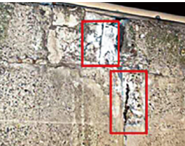
擁壁の損傷状況 （コンクリート剥離・鉄筋腐食）
