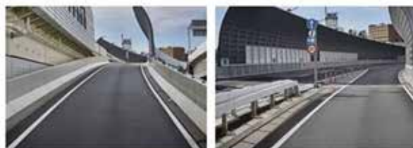
首都高合流部の例 特徴：右側合流、上り勾配、遮音壁設置、合流車線が短い等
