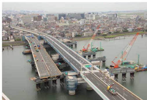
新設橋のスライド架設状況
