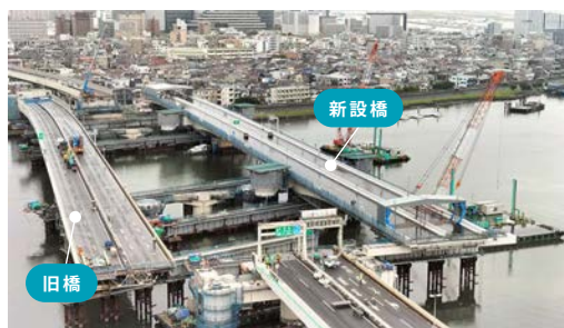
旧橋のスライド撤去状況
