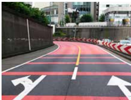
注意喚起カラー舗装
