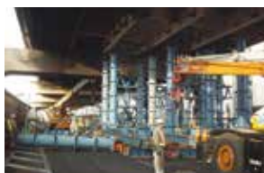
仮設バントの設置状況
