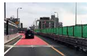
東側1車線を一時的に開放
