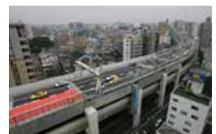
復旧ステップ 全線開通
