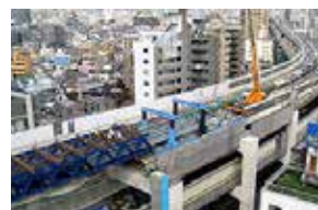
上層（西側）の新設状況
