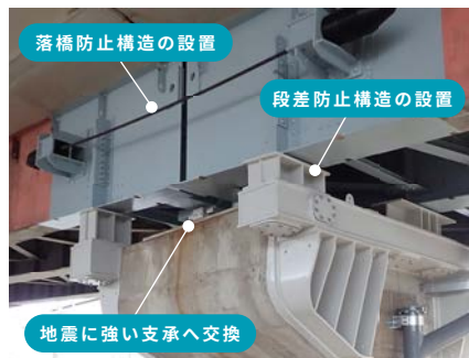
橋梁のさらなる耐震補強
