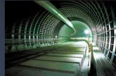
中央環状新宿線シールド工事
