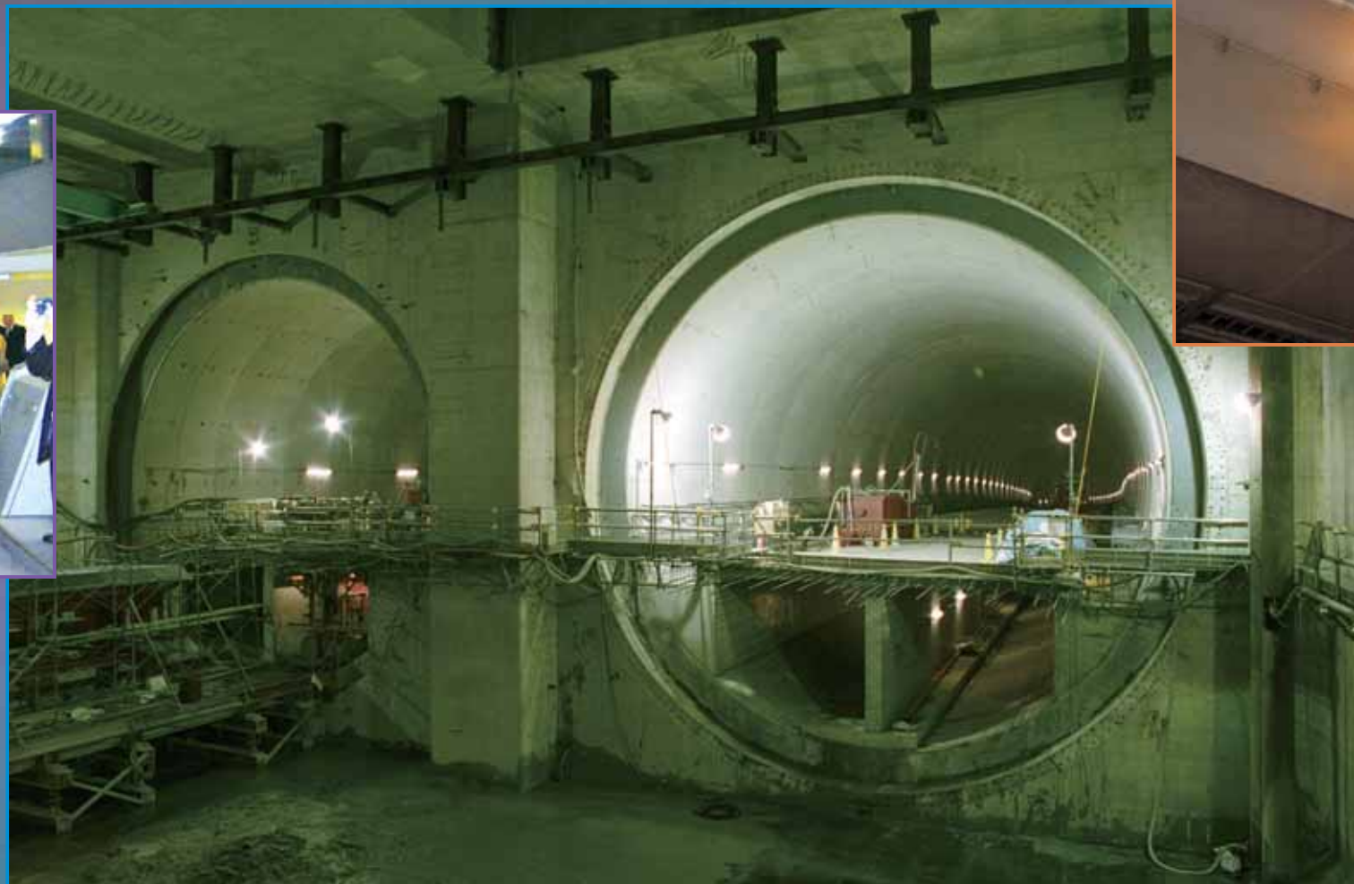
中央環状新宿線シールド工事
