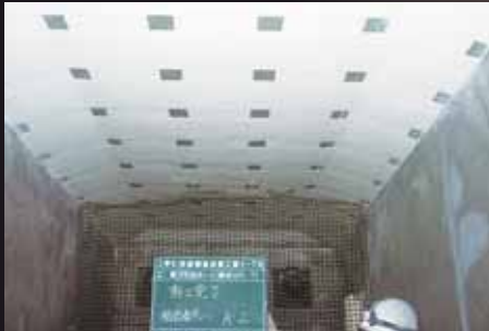
炭素繊維による補強
