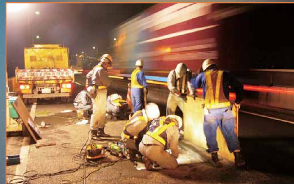
鋼床版き裂補修
