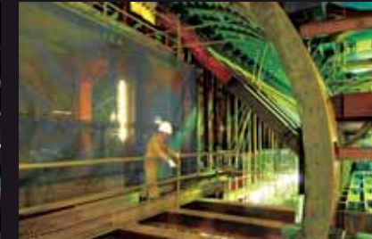
切り開き施工
