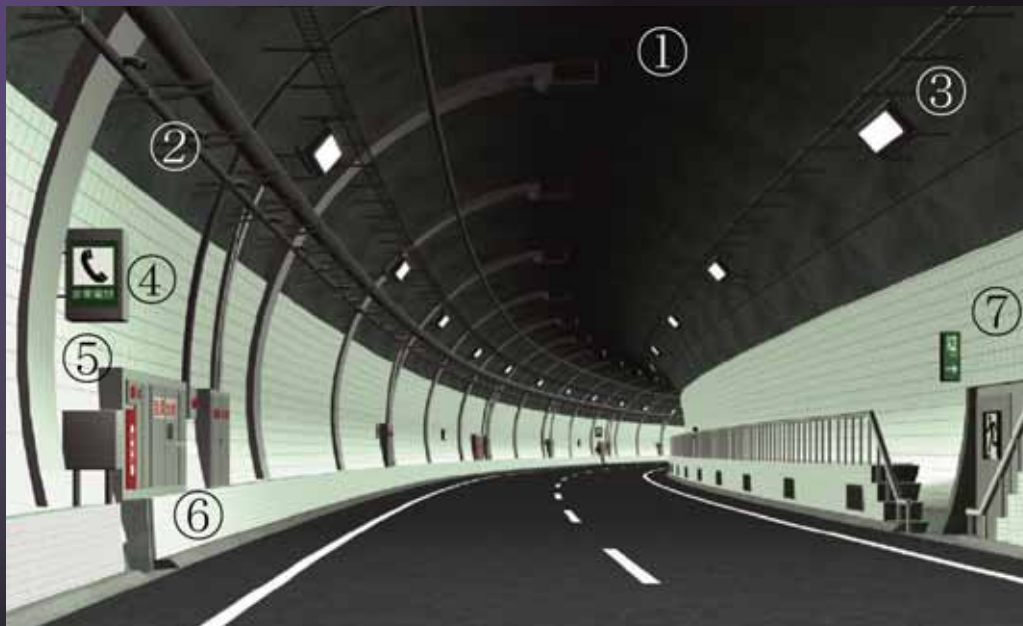
①排煙口(排気口) ②水噴霧設備 ③トンネル照明 ④非常電話 ⑤押ボタン式通報装置 ⑥消火器・泡消火栓 ⑦非常口
