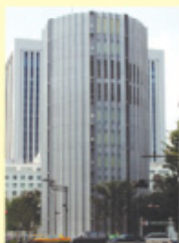
八重洲線八重洲トンネル 巖谷換気所 (東京都千代田区丸の内)
