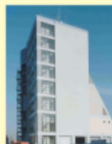
中央環状線飛鳥山トンネル 飛鳥山換気所 (東京都北区船橋一丁目地先)
