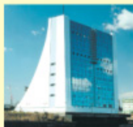
湯浅線東京港トンネル 大井換気所 (東京都品川区八潮)
