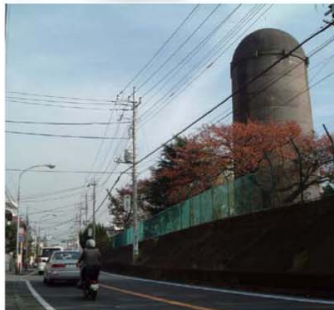
鶴見配水池と水道道 高さ26メートルの塔には、最大で680立方メートルが貯水可能でした。
