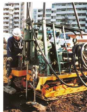
ボーリング削孔状況(イメージ)
