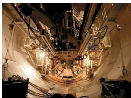
①-2 セグメント組立状況
