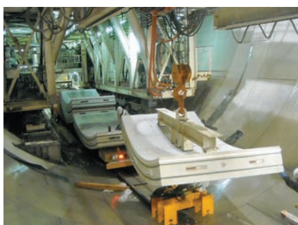
①-3 セグメント運搬状況
