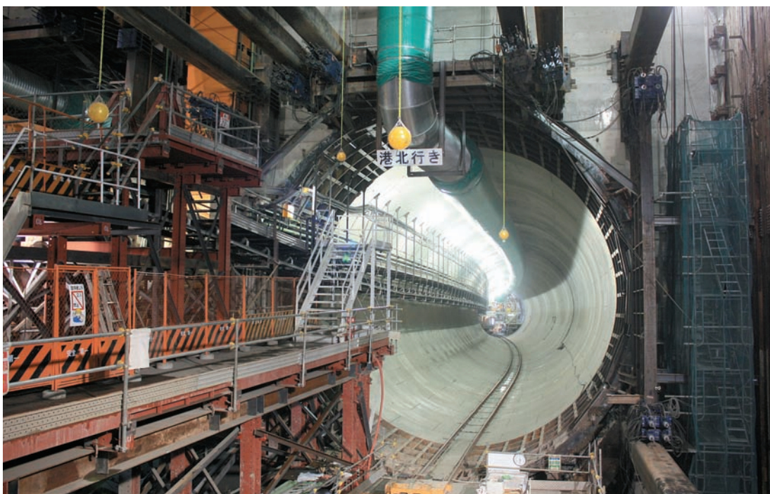
①-1 発進立坑部(コピー号)トンネル施工状況
