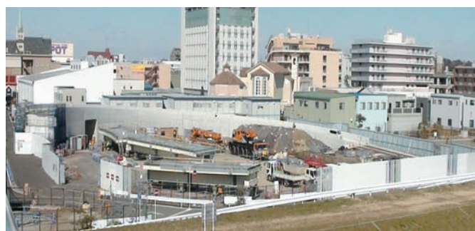
③-2 長島大竹線ループランプ橋桁地組状況
