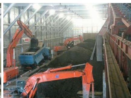
② 鶴見川遊水地部 土砂搬出状況
