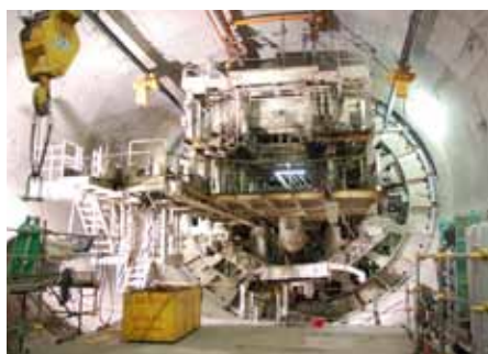
③-1 ※シールドトンネル内部状況 (ナッピー号解体状況)
