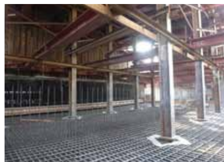
②-1 新横浜出入口部工事状況 (トンネル躯体構築工)
