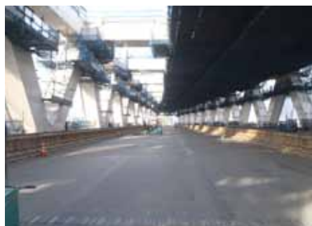
①-2 大竹橋付近工事状況 (床版上から)
