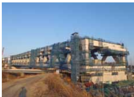
①-1 大竹橋付近工事状況 (全体)
