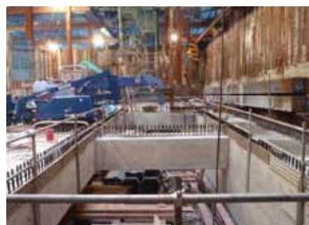
⑤ 新横浜換気所部工事状況 (躯体構築状況)
