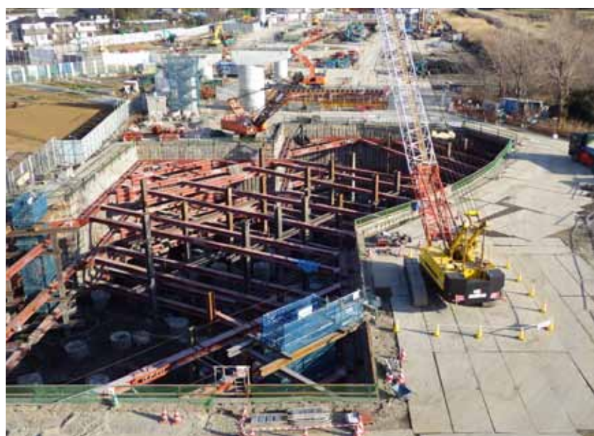
②-2 新横浜出入口部工事状況 (掘削土留工)
