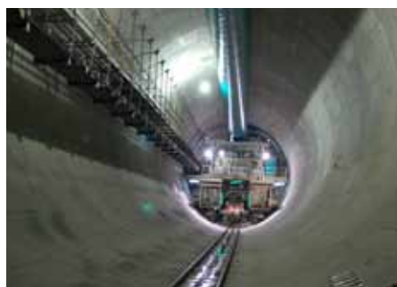
③-2 ※シールドトンネル内部状況 (コッピー号進捗状況)
