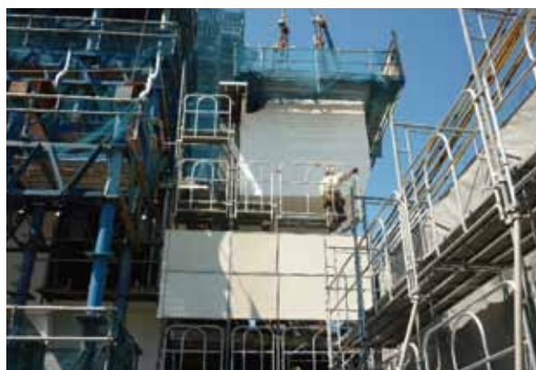
① 橋脚架設状況
