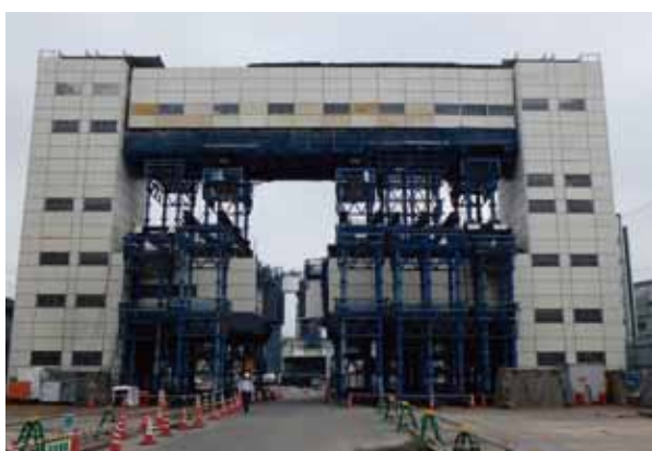
② 橋脚架設状況
