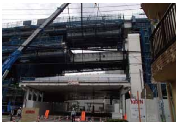
③ 橋げた架設状況
